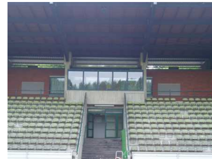
Tribüne mit Sprecherkabine
